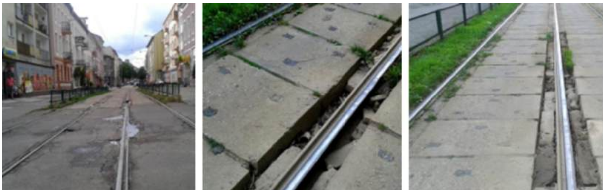
Rysunek 21 Niski poziom obsługi komunikacyjnej – infrastruktura tramwajowa
